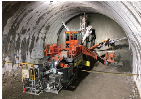
ロックボルト施工状況
