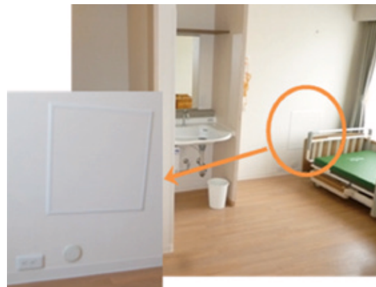
将来のベッドサイド水洗トイレを想定した プレ給排水管(壁内に隠す)
