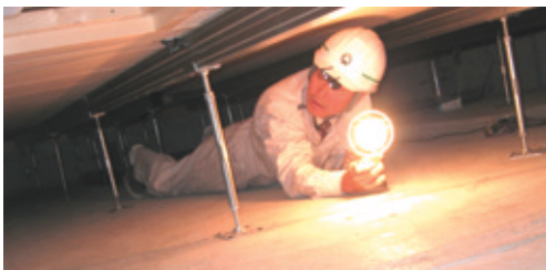
床下点検作業
