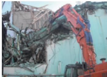
事例①：福島原子力発電所 原子炉建屋上部 瓦礫撤去工事
